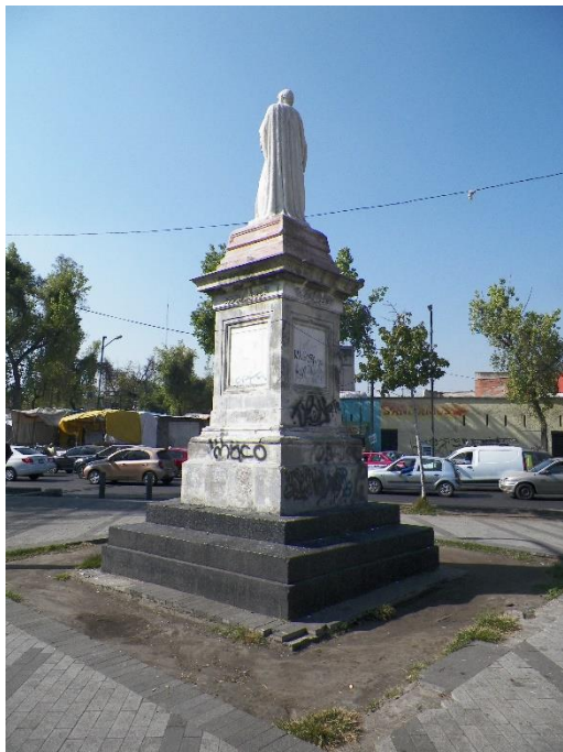
Foto 10. Fachadas Norte y Este (Fotografía Guillermo Escobar, 2022).
