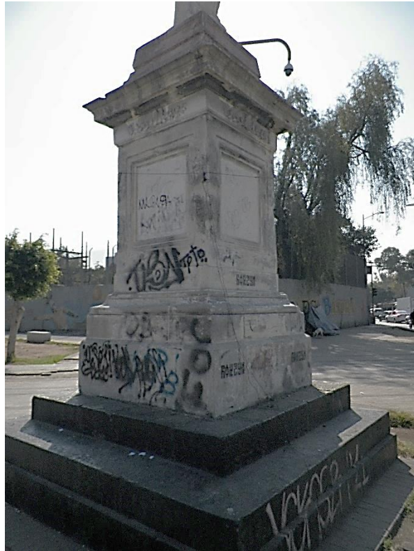
Foto 13. Detalle fachadas Norte y Oeste (Fotografía Guillermo Escobar, 2022).
