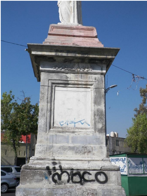
Foto 12. Detalle fachada Este (Fotografía Guillermo Escobar, 2022).
