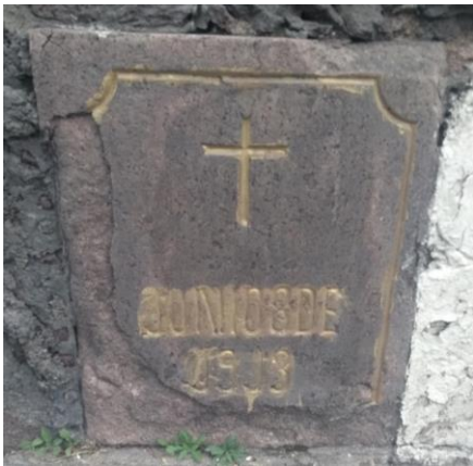
Foto 2. Placa en la entrada del panteón con la fecha de inicio de construcción de la barda (Fotografía Angélica Rivero López, 2019).
