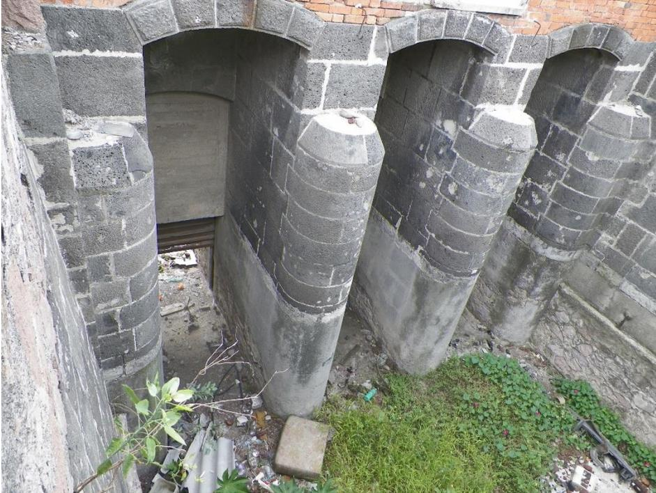
Foto 10. Arcos y columnas de basalto negro y gris de las compuertas (Fotografía Guillermo Escobar, 2021).
