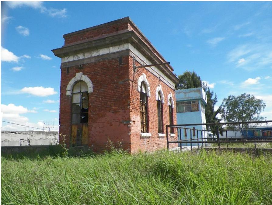
Foto 4. El cuarto de máquinas manufacturado en ladrillo rojo, mármol blanco y cantera rosa (Fotografía Guillermo Escobar, 2021).
