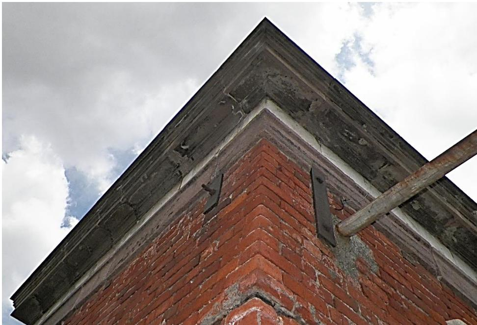
Foto 9. Barras rectangulares de hierro acerado, con el objetivo de darle soporte y firmeza a la construcción (Fotografía Guillermo Escobar, 2021).
